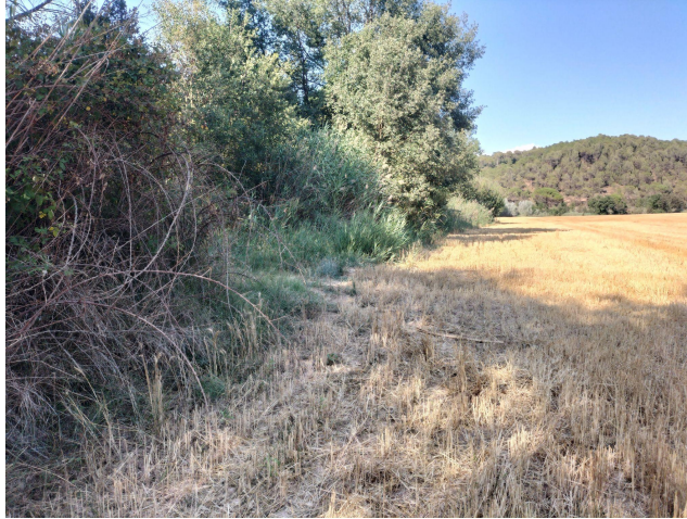
Figura 5. Renaturalización del recremento de las márgenes de la riera del Mugal para la protección de los cultivos ante las crecidas (ACA)
