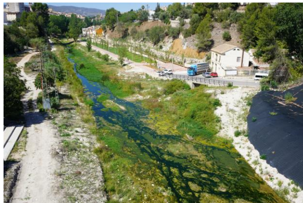
Figura 7. Vista del Parque fluvial “Les mamàs belgues” desde el Pont Nou
