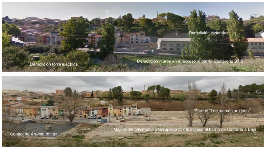
Figura 5. Avance de la restauración en el barrio de Cantereria Baja, antes (arriba) y después (abajo) de las obras (Google Maps, 2018 y 2024, respectivamente)
